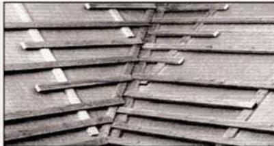
Желобок ендовой находится в плоскости контробрешетки. Конструкция применяется в случае ендовой, доходящей до карнизного свеса. В данном случае, водосливной желоб должен быть низкорасположенным.
