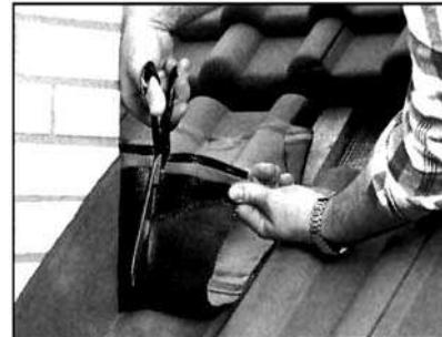
· Отрежьте нижнюю лишнюю часть рулона ножницами, скруглите углы нижней кромки. Приклейте подрезанные части к трубе и черепице и прокатайте роликом.
