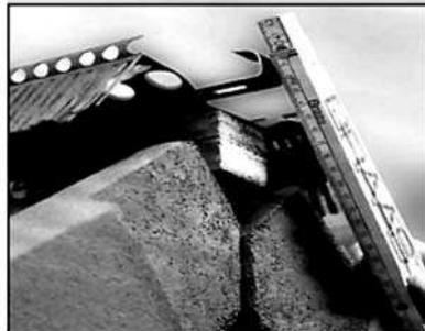
· Установите коньковую черепицу в зажим и закрепите её следующим зажимом при помощи оцинкованного шурупа **5x70 мм**.
