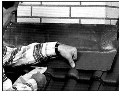
Разрежьте верхнюю не приклеенную часть **Вакафлекса** под углом **примерно 45°**, не дорезая **1 см** до точки пересечения ската и линии трубы. Приклейте роликом разрезанные участки на трубу и черепицу.
