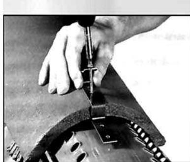
· Торцевой коньковый элемент закрепите на хребтовом бруске оцинкованными шурупами или гвоздями.
