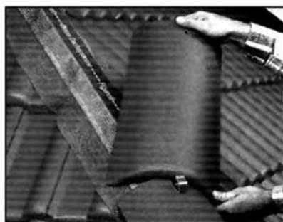
· За счёт продольного отверстия в зажиме примерно 1 см, уложите коньковые черепицы на обоих хребтах с шагом, необходимым для обеспечения симметричности установки крайних верхних коньковых черепиц.
