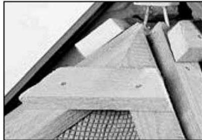
При дальнейшем набивании обрешетки подкладывайте под неё рейки или бруски нужной толщины, выравнивая плоскость ската.
