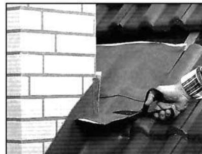
· Если над трубой возможно образование мешка, то для защиты кровли от проникновения талой воды во время оттепели **верхнюю кромку Вакафлекса отогните в виде отбортовки на 2...3 см.**
