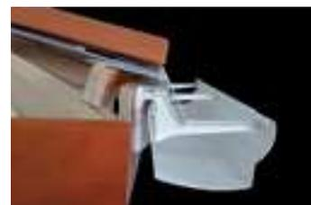
Гидроизоляционная плёнка укладывается поверх капельника. Плёнка крепится к капельнику скобами или гвоздями.
